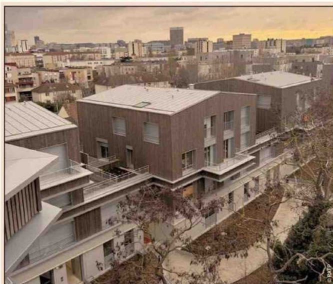
Le programme du Petit-Nanterre comprend 91 logements, dont 21 logements sociaux.
