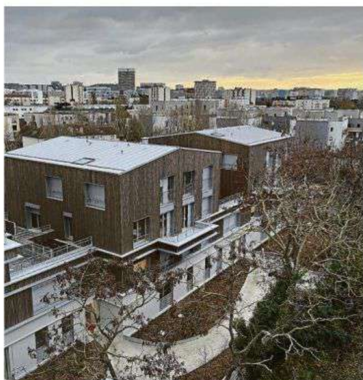
Le programme « Olympe de Gouges » de RATP Habitat a une approche de mixité avec 21 logements sociaux, 35 intermédiaires et 35 dans le cadre du dispositif du bail réel solidaire. Photo RATP Habitat
