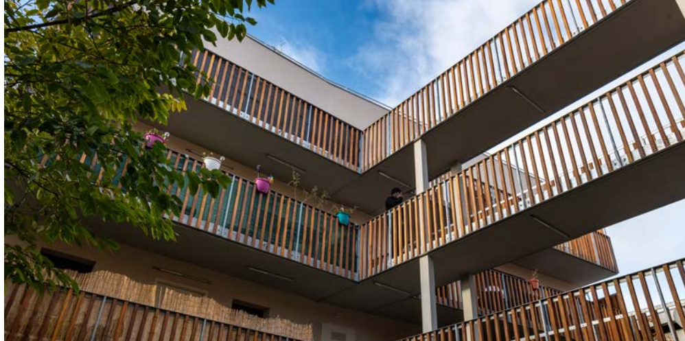
Livry-Gargan (93) - boulevard de la République. Réalisation d'une résidence de 12 logements locatifs sociaux et d'une surface de 90 m² destinée à la Ville. Maîtrise d'ouvrage : RATP Habitat Architecte : LA Architectures
