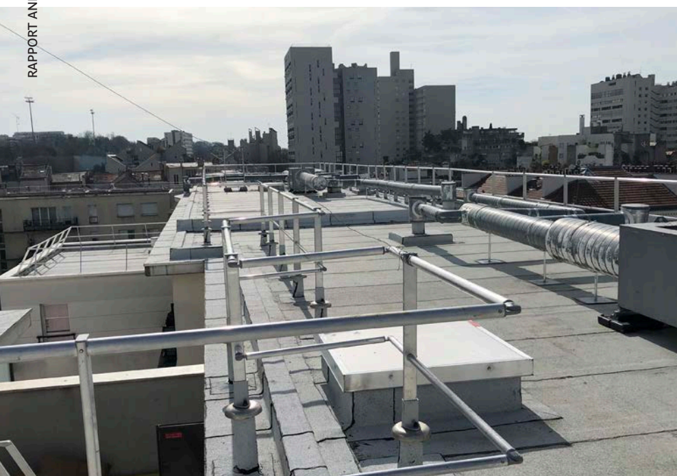
Ivry-sur-Seine (94) – résidence rue Rousseau Expérimentation de peinture de la toiture en blanc pour lutter contre les vagues de chaleur et faire baisser la température dans les logements. Installation de capteurs à l'intérieur de la résidence pour mesurer l'impact.
